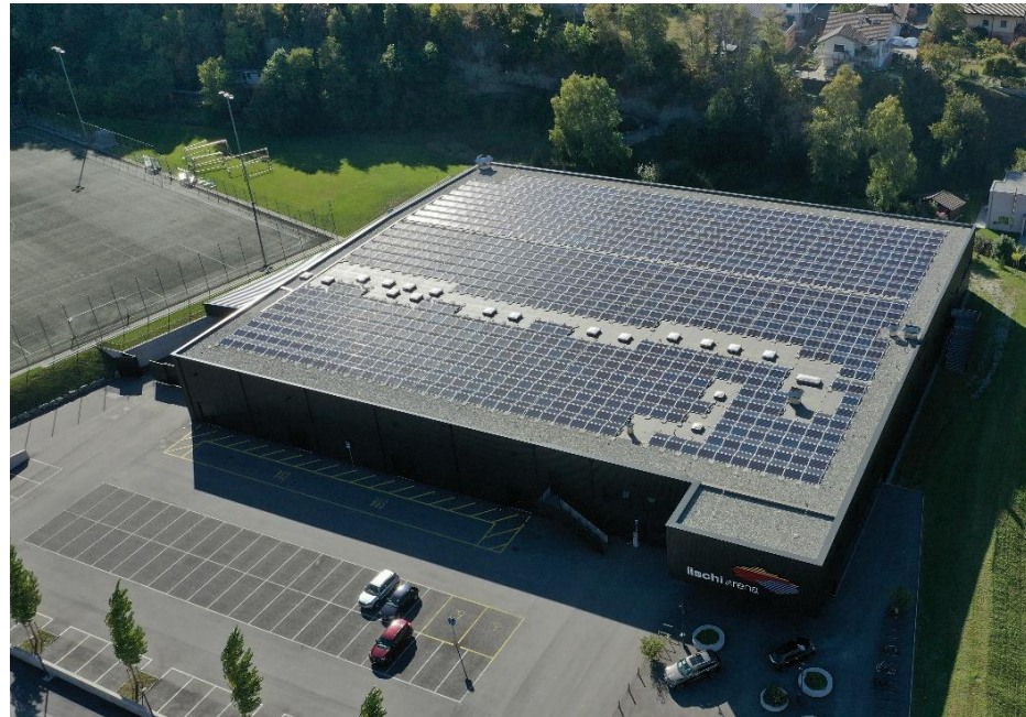
Itachi Arena: 510 kWp
